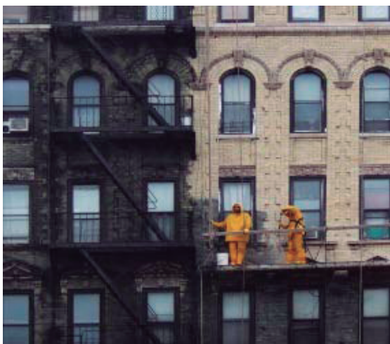
Limpieza de fachadas, todo tipo de acabados.
