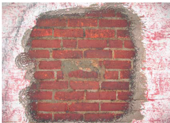
Remoción de morteros sobre muros.
